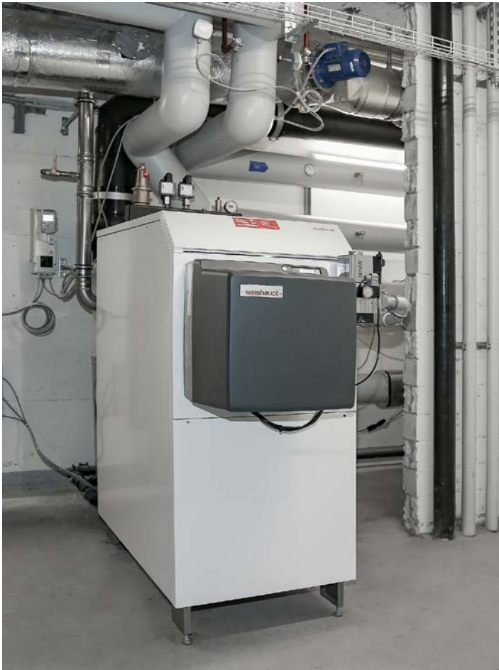
Geringer Platzbedarf: Gas-Brennwertsystem Thermo Condens 620 von Weishaupt.
