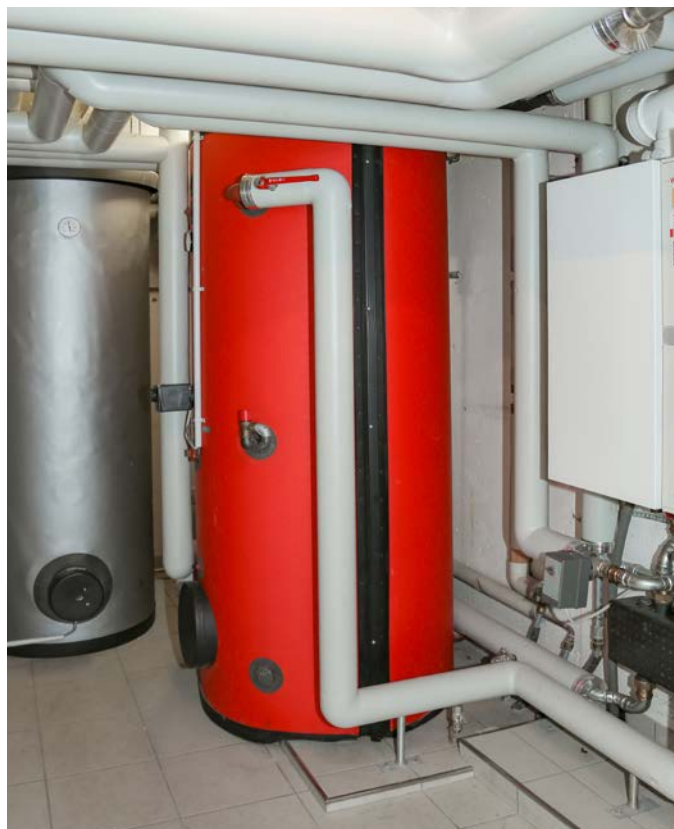
Bestehender Pufferspeicher und der Warmwasserspeicher; rechts im Bild der Wand-Gaskessel von Weishaupt, der die Spitzenlasten bei tiefen Temperaturen abdeckt. Die neu installierte intelligente Heizungssteuerung (im Bild nicht sichtbar) sorgt für den optimalen Betrieb der Wärmepumpe und das reibungslose Zusammenspiel mit dem Gasbrenner.
