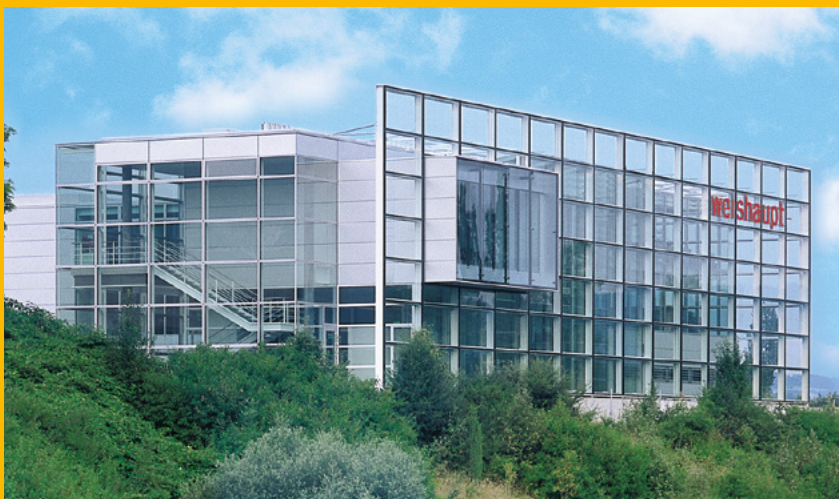
Schulungs- und Verwaltungsgebäude in Geroldswil (ZH)
