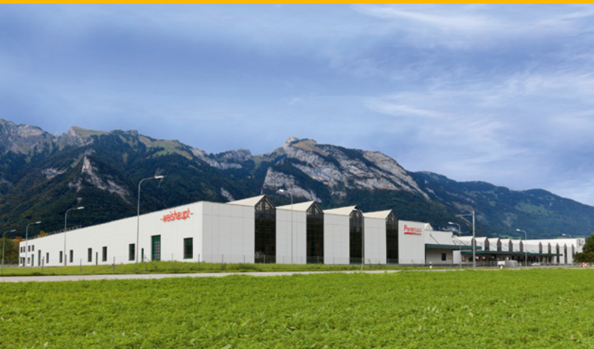
Pyropac AG, Sennwald (Kanton St. Gallen), Produktionsbetrieb für Weishaupt Heizsysteme
