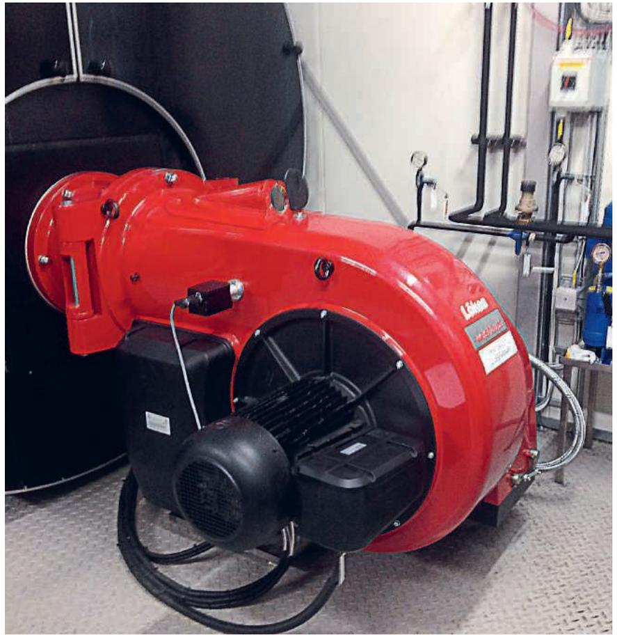
**Der schwedische kommunale Energieversorger Söderhamn Nära liefert Fernwärme mit dem Brennstoff HVO mittels eines Weishaupt monarch®-Ölbrenners WM-L 50.**
