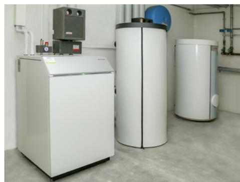
Die Biblock® WBB 20-A-RMD-AI wurde mit einem Pufferspeicher PSM 300 und einem Trinkwasserspeicher WAS 300 LE / Eco ergänzt. Alle Geräte werden in der Schweiz hergestellt.
