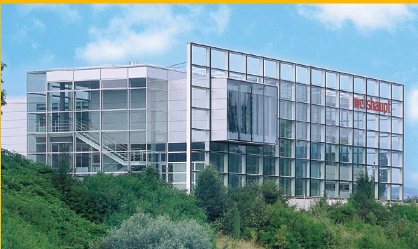
Schulungs- und Verwaltungsgebäude in Geroldswil (ZH)
