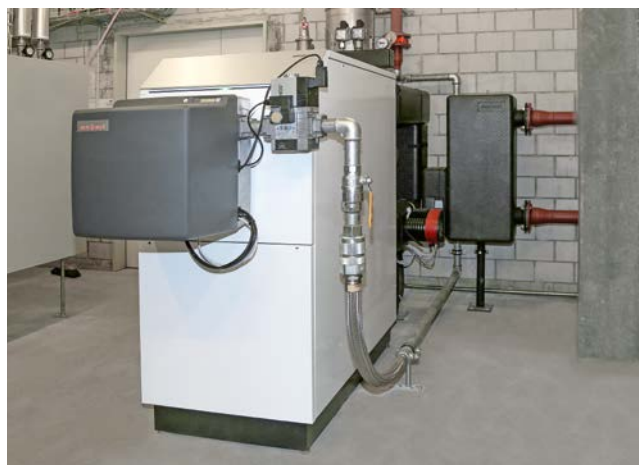
Weishaupt-Thermo-Condens-620-Gas-Brennwertkessel.
