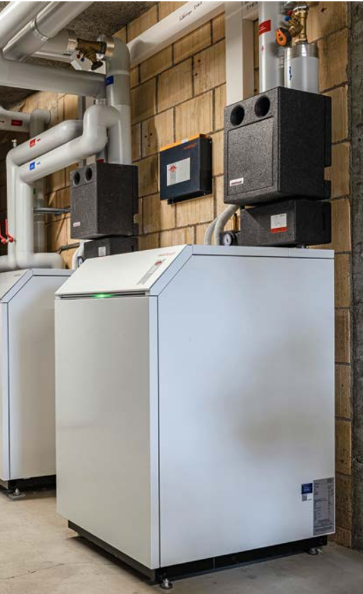
Eine kompakte, hocheffiziente Lösung: Kaskade mit zwei High-End-Luft/Wasser-Wärmepumpen Biblock® WBB 20-A-RMD-AI, ergänzt mit einem Energiespeicher WES 500-HP und einem Trinkwasserspeicher WP/E 1000.
