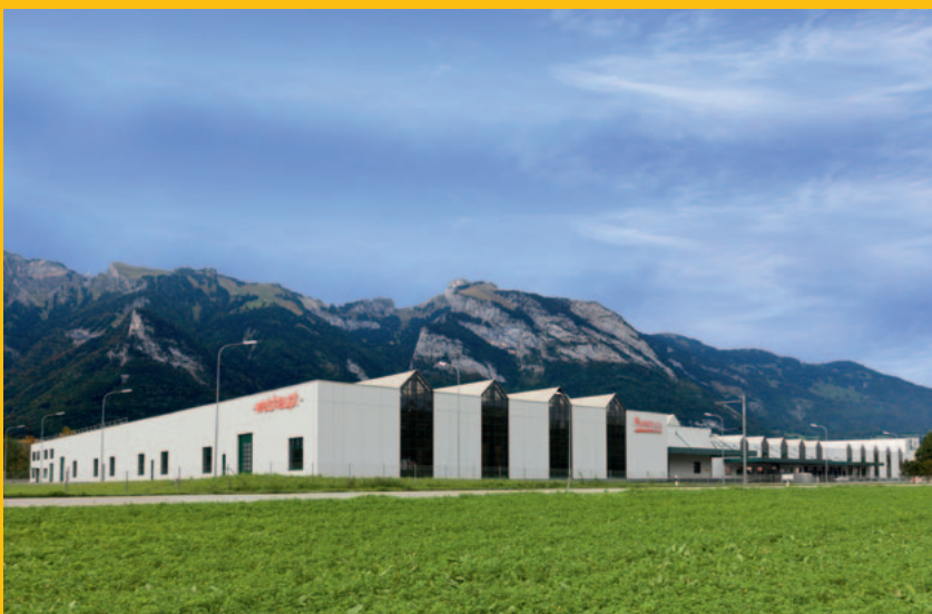
Pyropac AG, Sennwald (Kanton St. Gallen), Produktionsbetrieb für Weishaupt Heizsysteme
