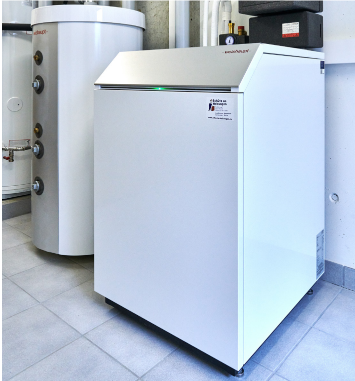
Der innovative Kältekreis sorgt für einen modulierenden Betrieb und arbeitet zuverlässig bei Aussentemperaturen von bis zu -22 °C.
