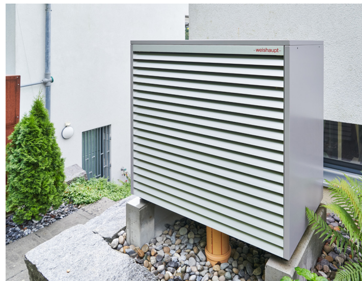
Das Aussengerät mit innovativem Eulenflügel-Ventilator zählt zu den leisesten Geräten am Markt.
