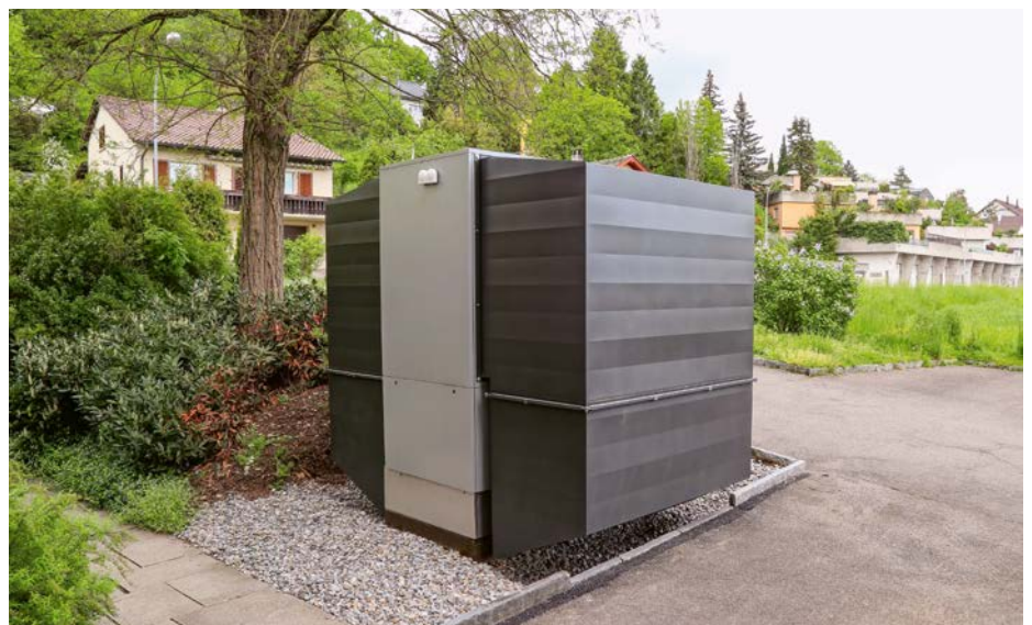
Die Luft-Wasser-Wärmepumpe Weishaupt WWP LA 60-A R mit rund 40 kW Heizleistung.
