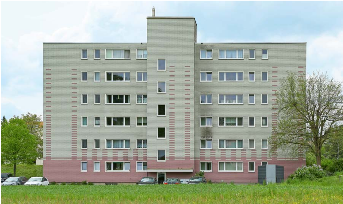
Für 12 Wohnungen ein erhebliches Gebäudevolumen: Kirchbergstrasse 50, Schaffhausen. Nicht sichtbar die Photovoltaik-Anlage auf dem Dach.
