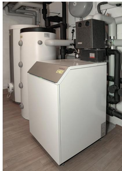
Aus 1 kW Strom gewinnt eine Weishaupt «Geoblock®»-Wärmepumpe bis zu 5 kW Heizleistung. Damit gehört sie zu den besten Sole/Wasser-Wärmepumpen auf dem Markt. Davon profitieren jetzt die Besitzer eines Einfamilienhauses in Lantsch nach der Erneuerung ihres Heizsystems.
