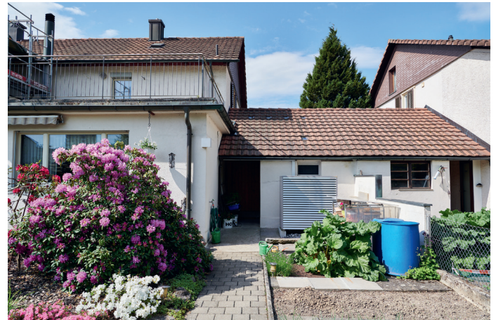
Der Schalldruckpegel des Aussengeräts beträgt bei einer Entfernung von 3 Metern nur 35 dB(A). Das lässt nicht nur die Bewohner, sondern auch die Nachbarn ruhig schlafen.
