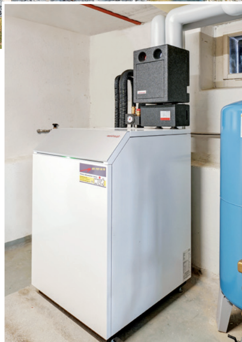
Das Innengerät der Weishaupt Biblock Wärmepumpe mit dem modulierenden Scroll-Verdichter.
