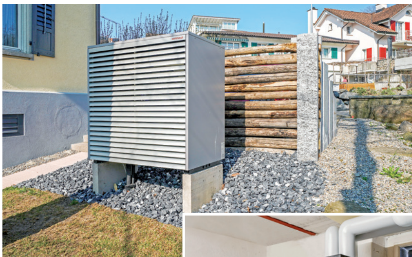
Das vollverzinkte Aussengerät mit nach unten gerichteten Lamellen.
