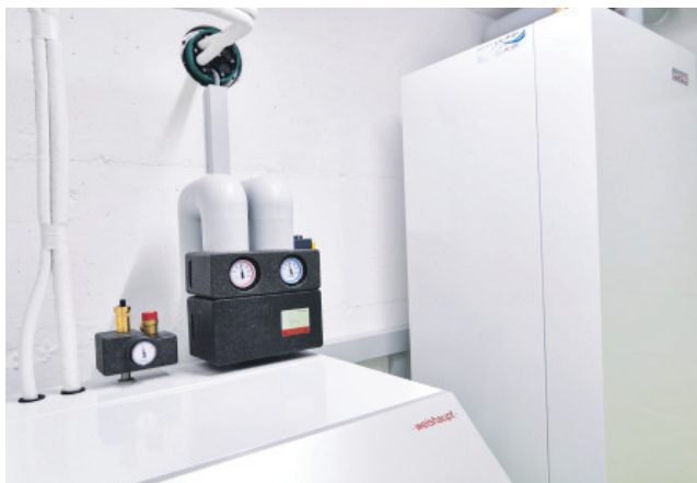
Vor- und Rücklaufanschluss mit integriertem Luft- und Schlammabscheidsystem.
