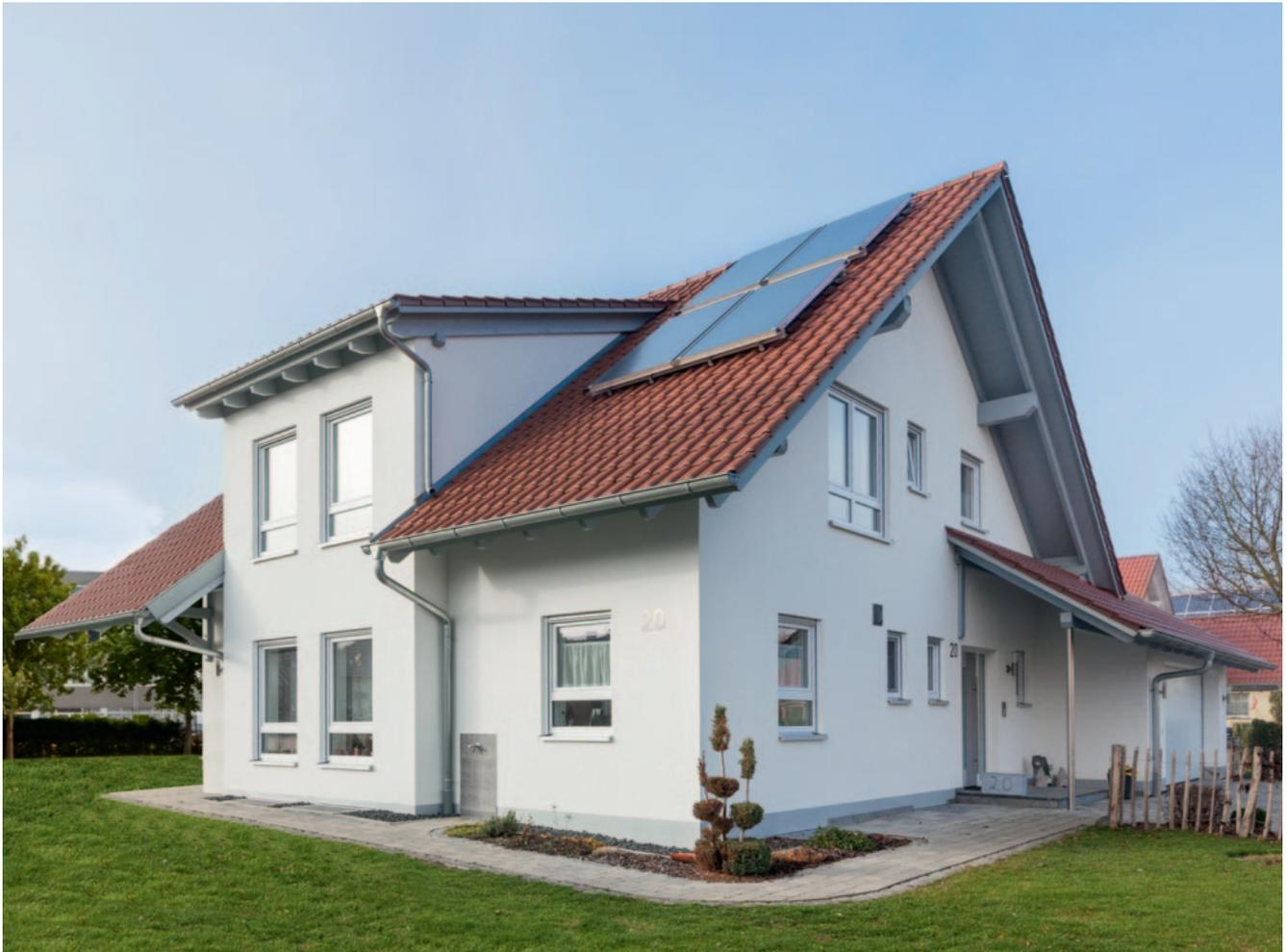
*Kollektoranlage zur kombinierten Trinkwassererwärmung und Heizungsunterstützung*
