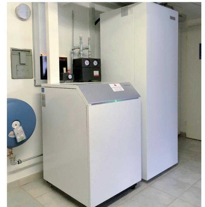
Das Innengerät der Wärmepumpe.
