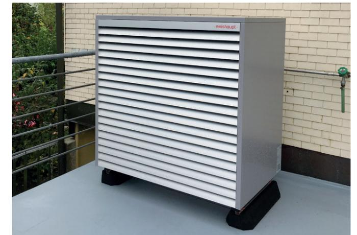
Das Aussengerät der Wärmepumpe.
