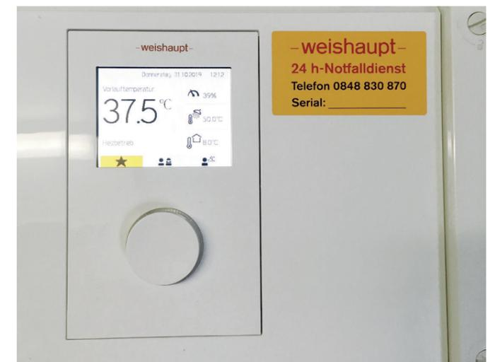
System-Bediengerät mit Farbdisplay und Klartextanzeige.
